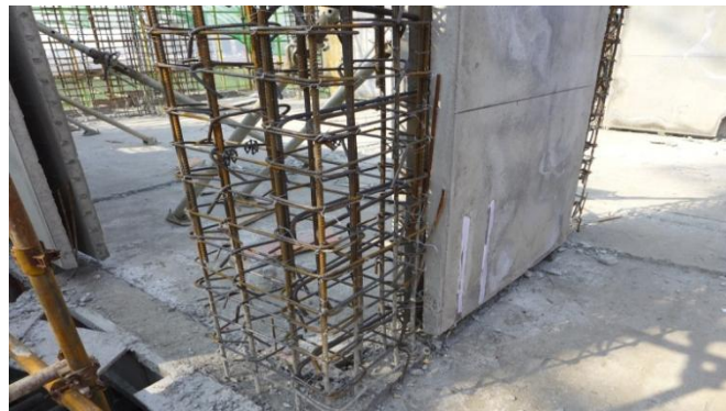
浙江宝业在合肥保障房工程上预制双皮墙结构体系应用
