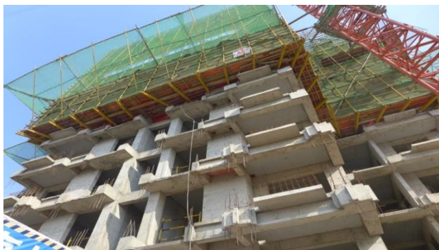
浙江宝业在合肥保障房工程上预制双皮墙结构体系应用
