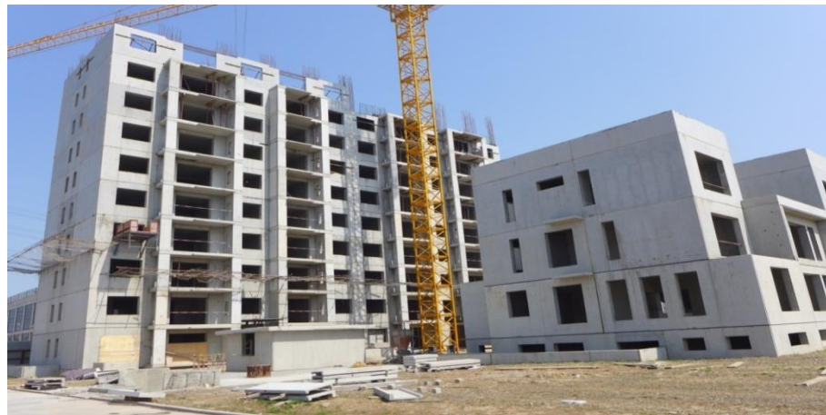
江苏元大的双板墙试点工程应用
