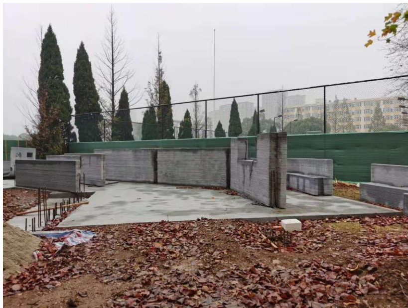
东南大学成贤学院正在施工3D打印的茶吧
