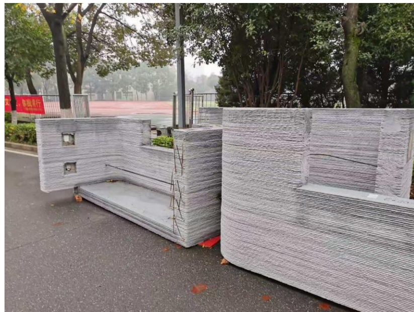
东南大学成贤学院正在施工3D打印的茶吧
